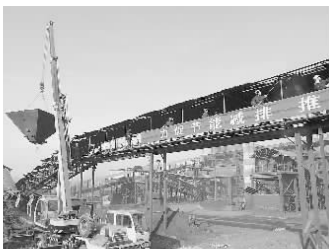
12月23日,邢台市龙海钢铁集团的一座高炉设施被拆除。为贯彻落实国家节能减排方针,淘汰落后产能,改善大气环境,河北邢台开始拆除两座220立方米高炉,此次拆除可有效改善当地环境质量。
